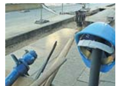
225.000 Euro werden in Strom-, Gas- und Wasserleitungen investiert. FOTO: ILL
